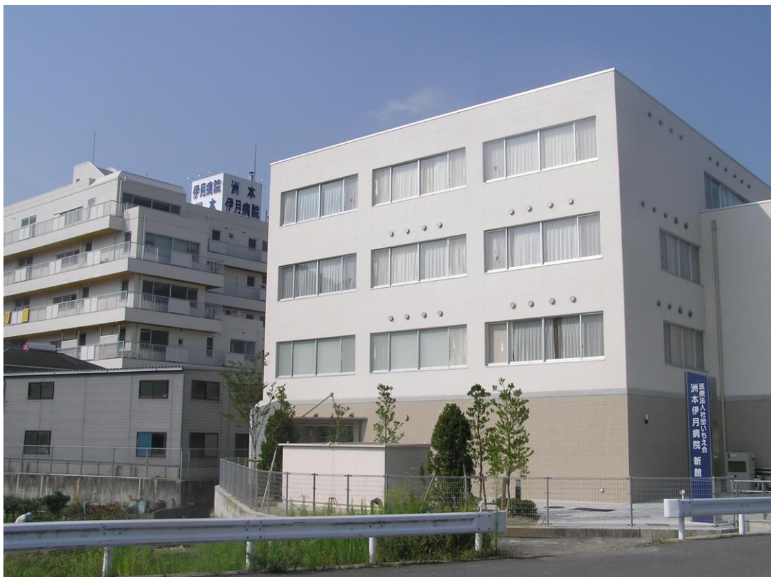
本館の裏側にある新館
